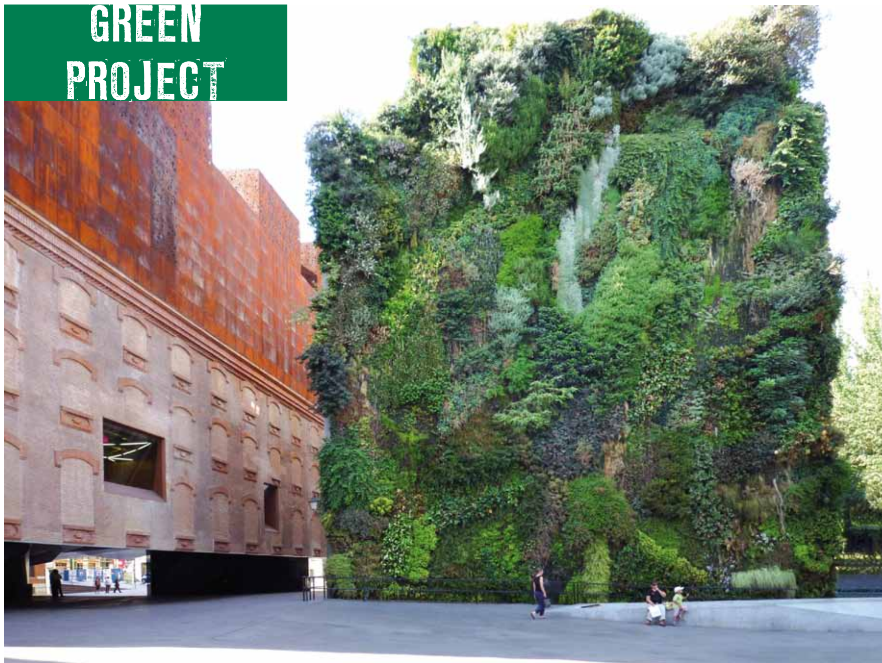
La CaixaForum di Herzog & de Meuron a Madrid
